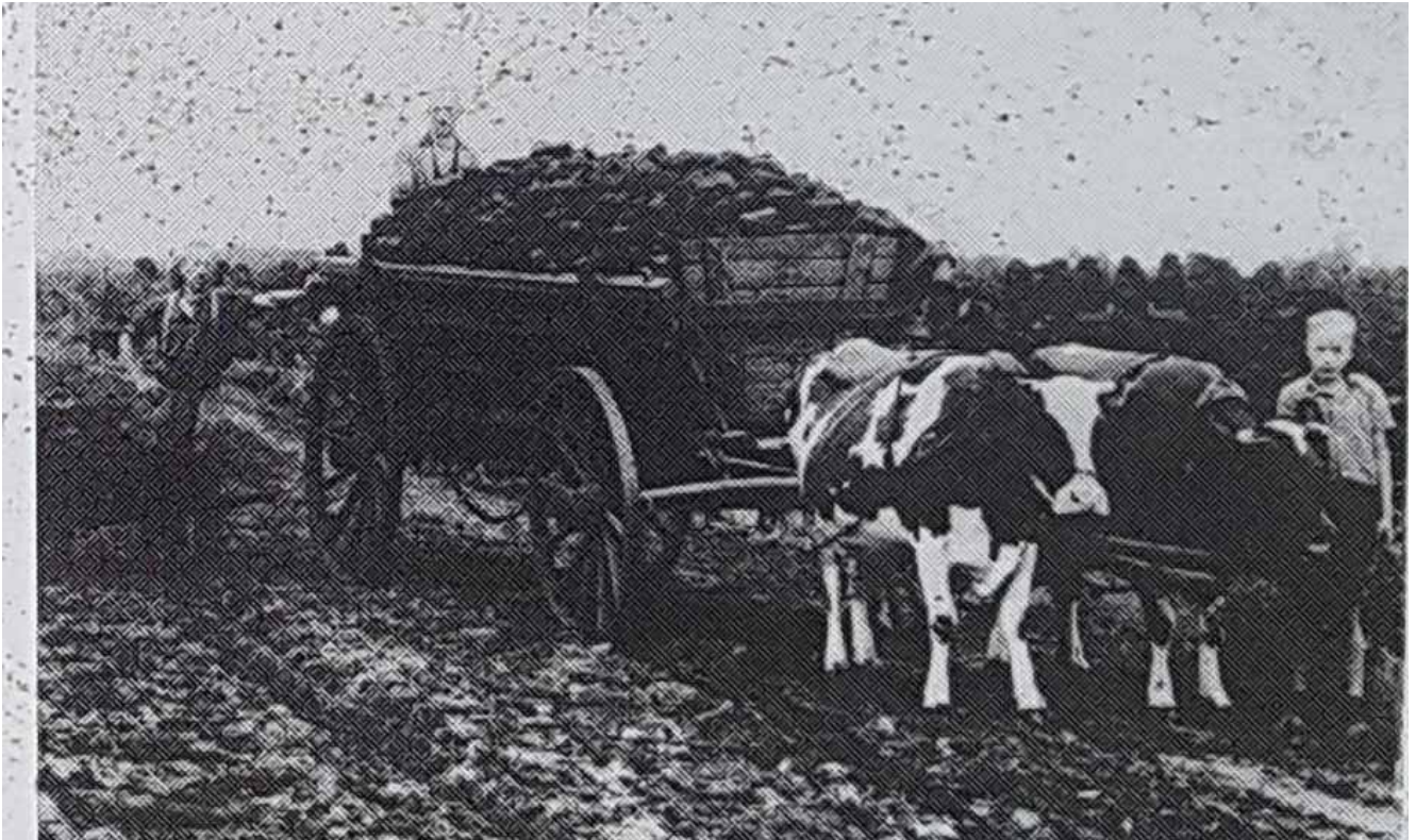
Der Torf wird abtransportiert
